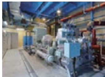
タービン発電機
